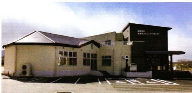
4月オープンに向け内装作業が進行(旧菩提寺まちづくりセンター)
