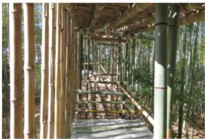
バンブーハウス2号の床板補修
