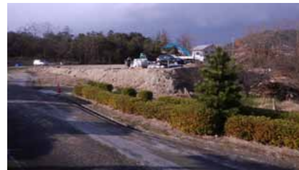
工事が始まる
