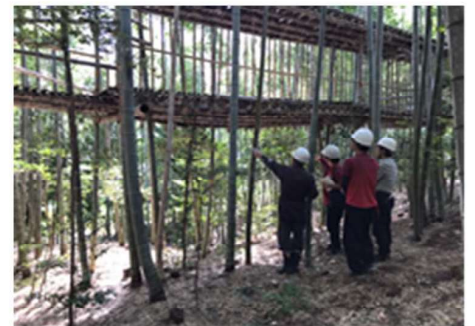
2号機補修中の県立大生
